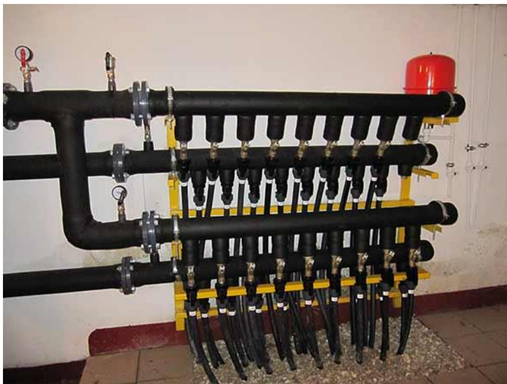
Рис. 3. Коллекторы геозондов.
